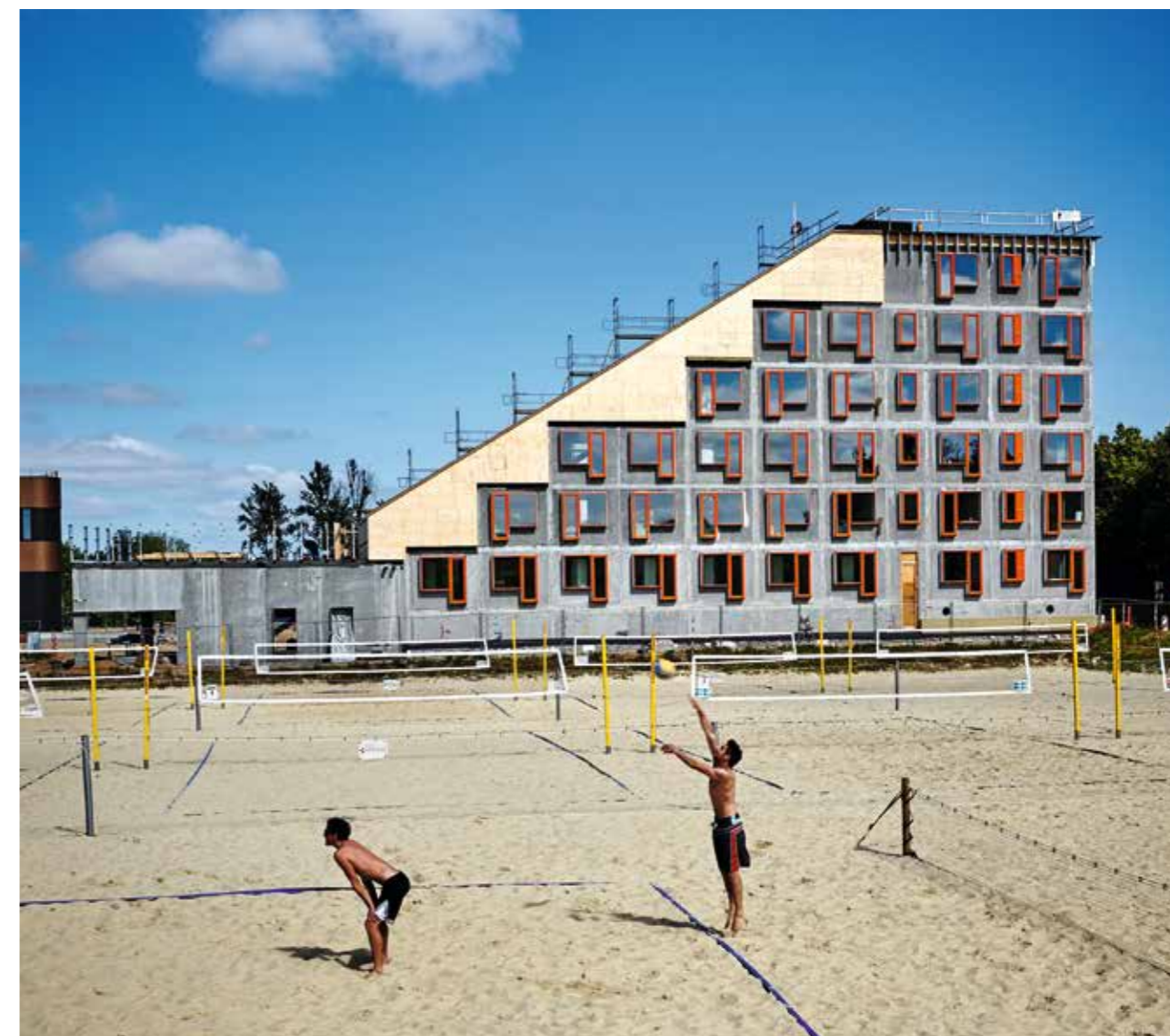
Campus Living Kolding Ungdomsboliger i Kolding tæt på vand og centrum.
